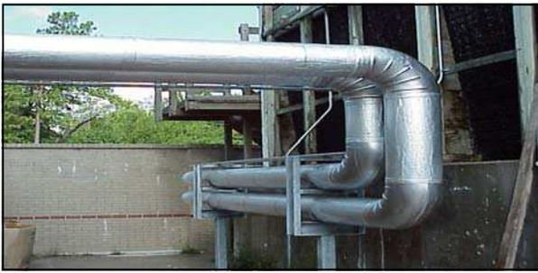
La gaine **Alumaguard® All-Weather** ne doit être utilisée que sur un panneau isolant revêtu de fibre de verre ou de mousse plastique à alvéoles fermées.
